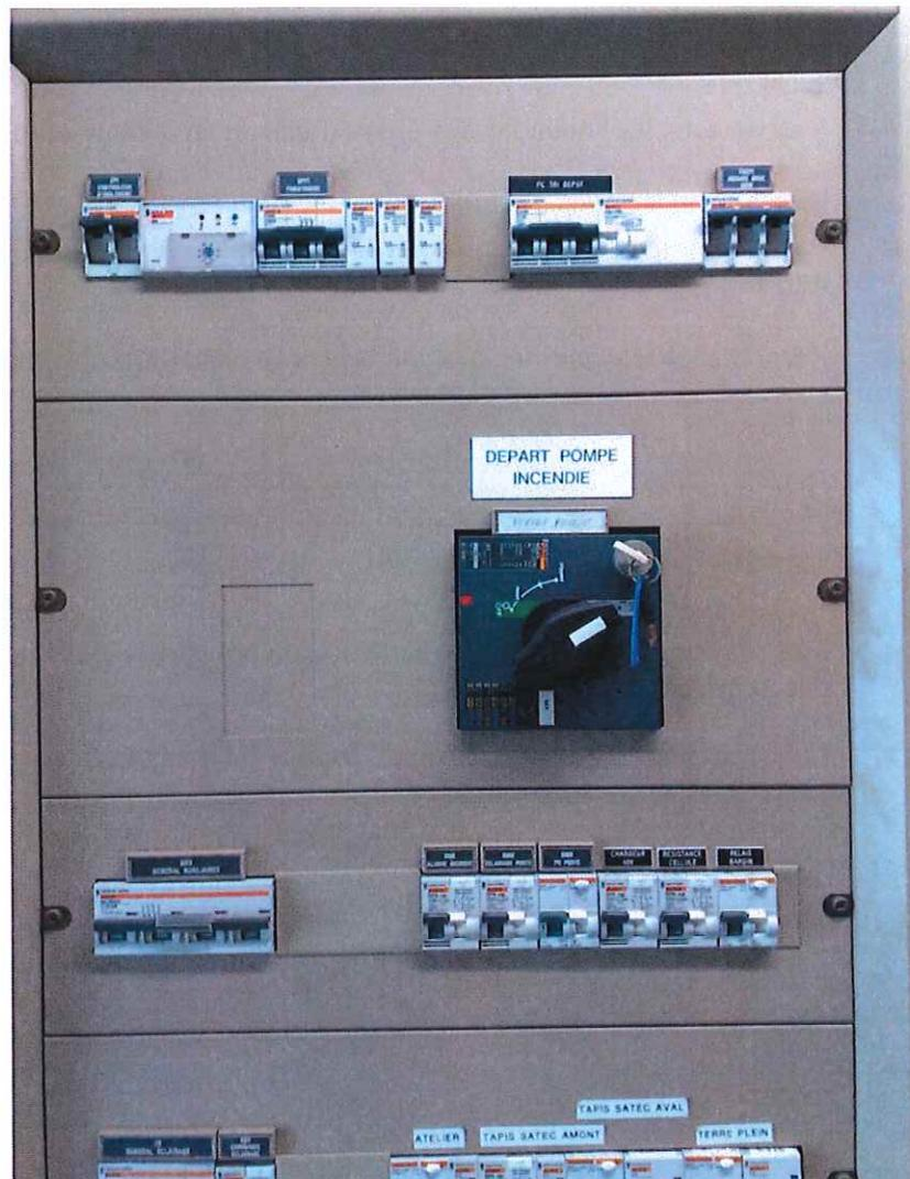
Même en dehors des périodes d'utilisation du dispositif, le commutateur « Départ Pompe » doit rester sur la position « ON » (pour réchauffage de l'armoire de commande).
