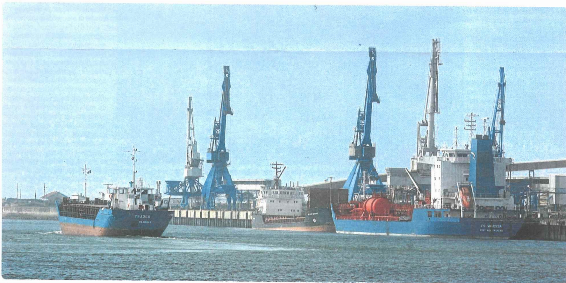
Le port de Bayonne envisage de développer ses infrastructures en lançant des travaux d'agrandissement des quais.
