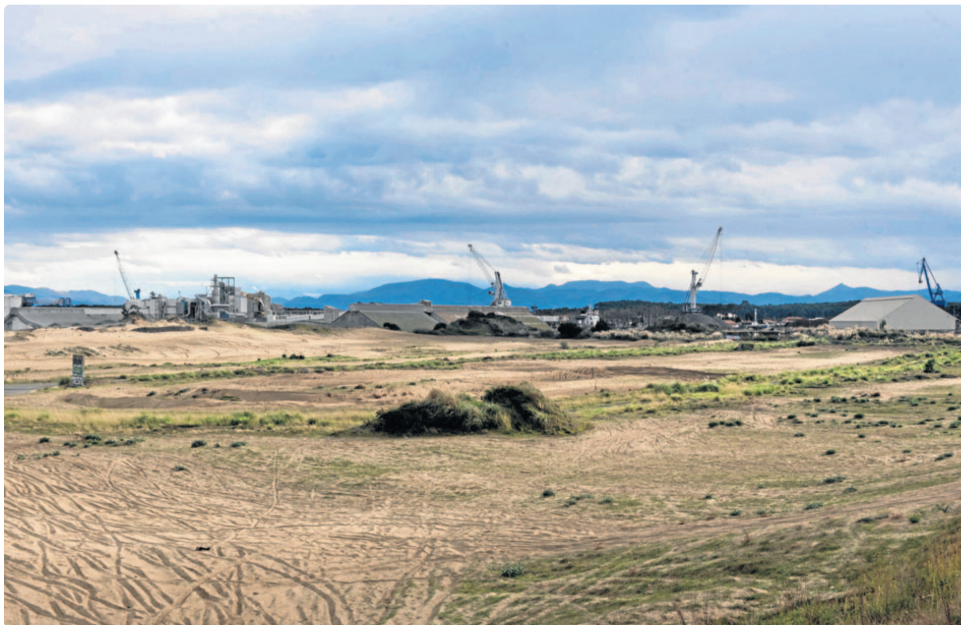
Le Laminier des Landes à Tarnos pourrait fabriquer des mâts d'éolienne.
